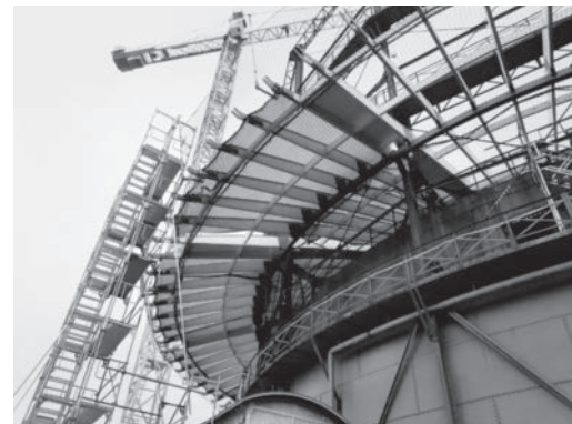
Blick von unten auf die Kragträger. Die Montage der Membrane ist im Gang
