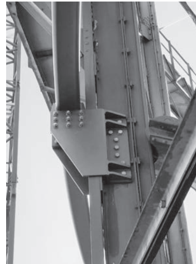
Die Stahllaschen an den Gerüststielen und der Ringträger sind montiert
